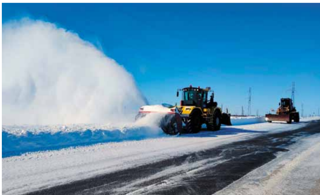
До активного таяния грунтов важно уберечь дороги от разрушения
